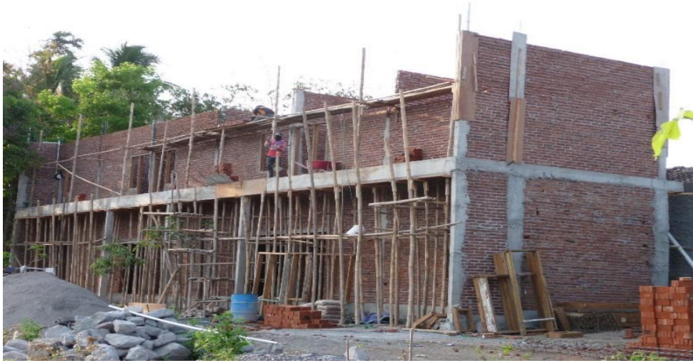
तस्वीर 3. प्रबलित कांक्रीट (reinforced concrete) और ईंट से एक संकुचित चिनाई (confined masonry) भवन का निर्माण ।
