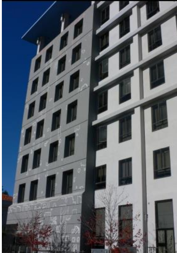
तस्वीर 3. इस मकान के आखिरी हिस्से में तुलनात्मक मोटी संरचना देखी जा सकती है जो कि पुराने फ्रेमवर्क (framework) के ऊपर कांक्रीट का नया फ्रेमवर्क है।
