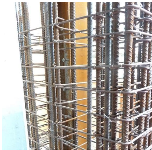
तस्वीर 3. स्तम्भों में कांक्रीट डालने से पहले स्टील से बनी छड़ें देखी जा सकती हैं। ये छड़ें नीचे से ऊपर की दिशा में होती हैं, और वलय (bending) का प्रतिरोध करती हैं। इसके अलावा धरती के समानांतर छड़ें कांक्रीट को टूटने और अलग होने से रोकती हैं।
