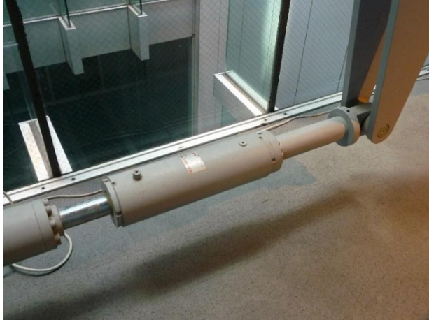
तस्वीर 3. भूकंप के दौरान कम्पन कम करने के लिए उपयुक्त डैम्पर (damper) ।
