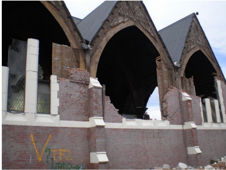
تصویر (۴)۔ اس مکان کی زیادہ تر باہری دیواریں (claddings) اور شیشے (glazing) ایک زلزلے کے دوران ٹوٹ پھوٹ کا شکار ہو گئے۔
